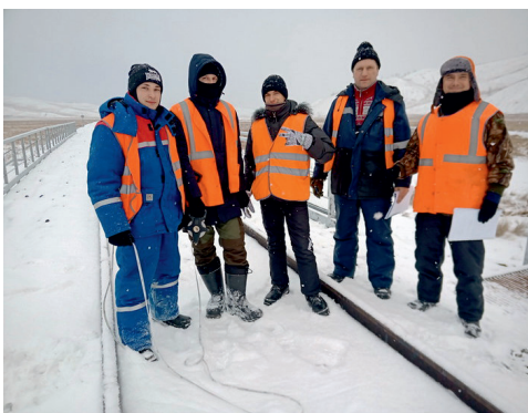
ЖЕЛЕЗНАЯ ДОРОГА «НАРЫН – ЛУГОКАН». ОБСЛЕДОВАТЕЛЬСКИЕ РАБОТЫ ДЛЯ ПОДГОТОВКИ ДОКУМЕНТАЦИИ ПО ВВОДУ ОБЪЕКТА В ЭКСПЛУАТАЦИЮ
